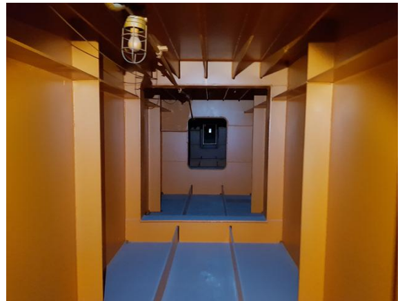
거더 내부 전경
